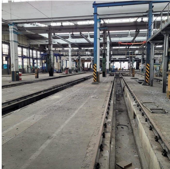
Blick in die Halle des ehemaligen Bw 1
